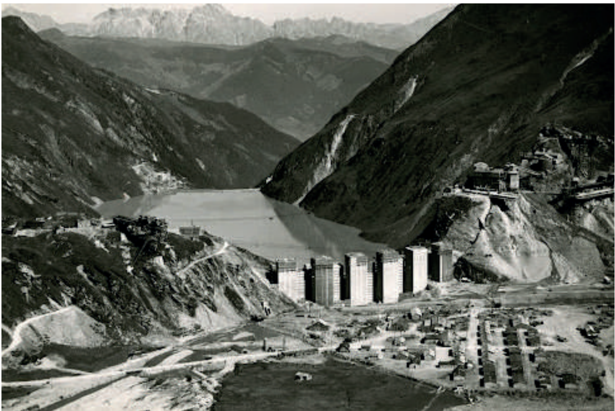
Abbildung 2: Kraftwerk Kaprun mit Blick auf die Leoganger Steinberge.
